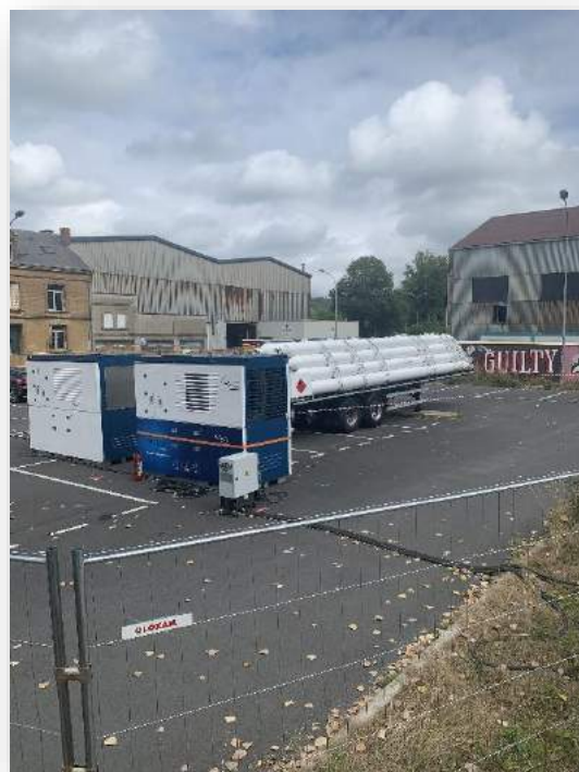
Groupes électrogènes à hydrogène testés au cabaret vert
