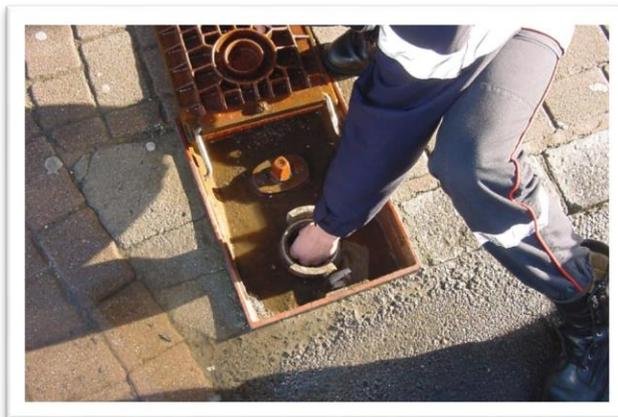
③ Vérifier la qualité des bouchons et des joints puis l'état général de l'hydrant (peinture, coffre, accessibilité aux engins de secours, bon état de l'ancrage, etc.) ; Reporter les anomalies sur la fiche de contrôle.
