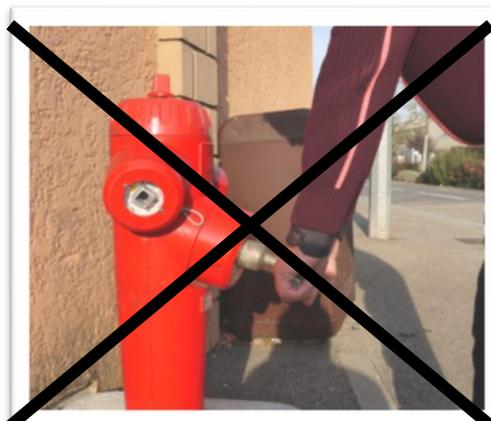
**Ouvrir lentement et totalement le PI par palier** jusqu'à l'apparition de l'eau propre. **Refermer ensuite le PI lentement et par palier** afin d'éviter les coups de bélier (surpressions violentes) dans l'installation. Vérifier par l'orifice de la prise symétrique que la vidange fonctionne, dans le cas contraire, signaler l'anomalie sur la fiche de contrôle.
